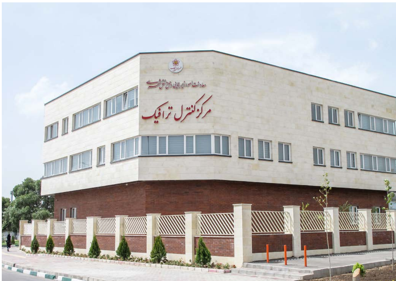
کنترل ترافیک شهرداری زنجان
